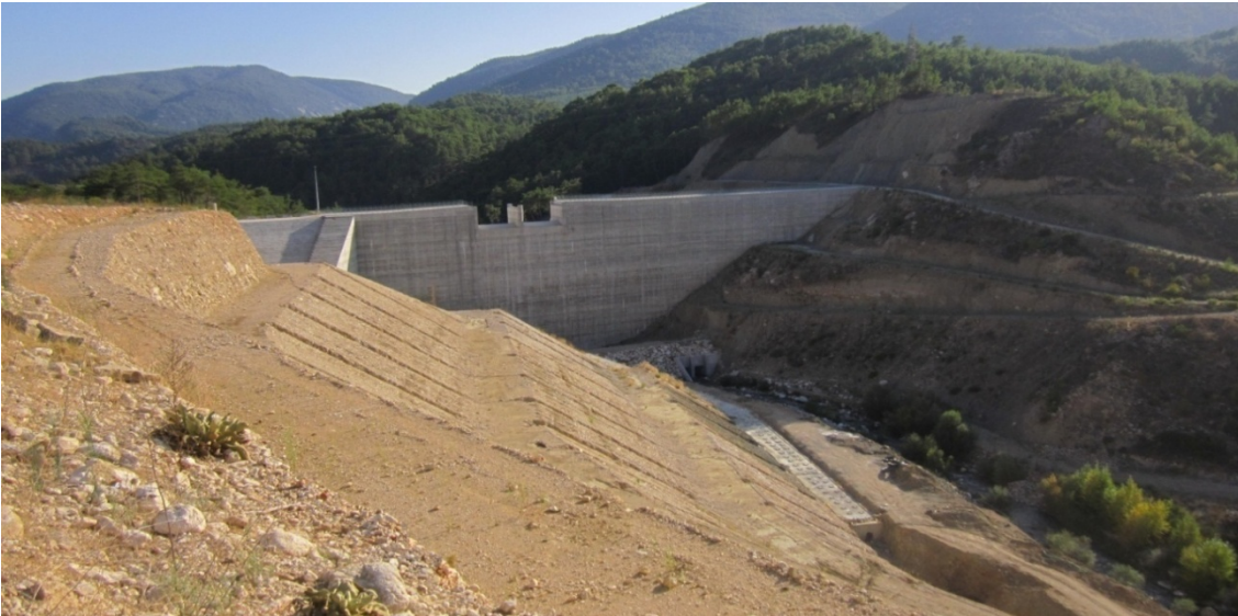
Fotoğraf 6. Kapıçay Barajı
