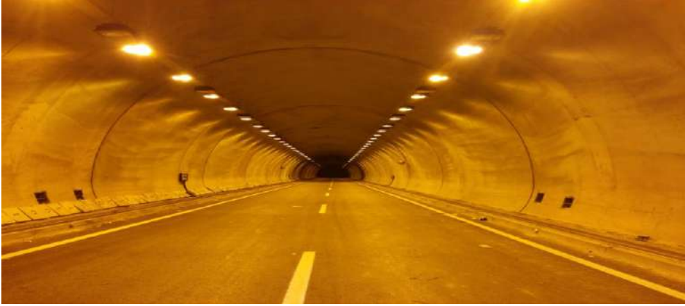
Şekil 2. Sodyum Buharlı Yüksek Basınçlı Armatürle Aydınlatılmış Tünel[2]
