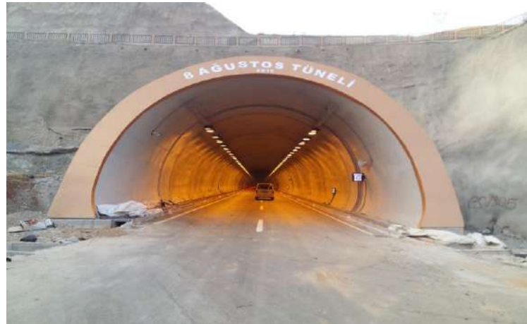
Şekil 1. Tünel Aydınlatması[2]
